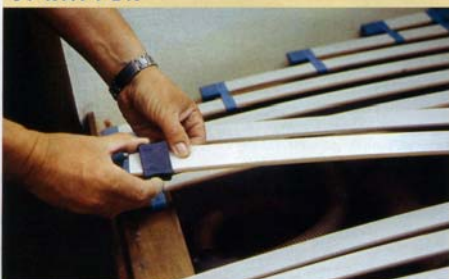
Nach der leichten Anpassung verbindet man jeweils die Enden zweier Federleisten mit rutschfesten, flexiblen Kautschuk-Kappen.
